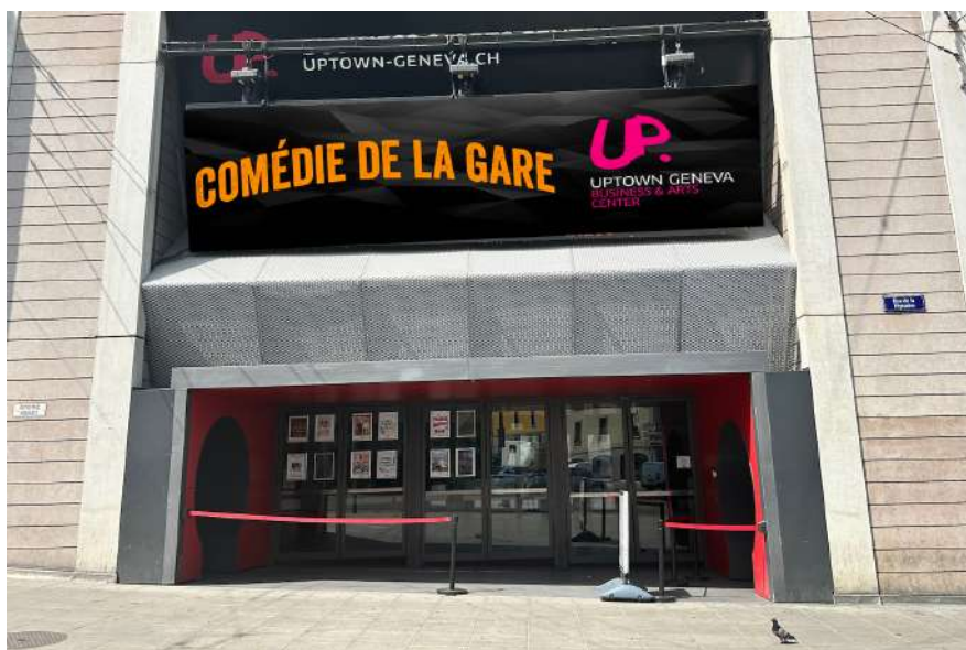
Image 6 - Accès par l'entrée principale
