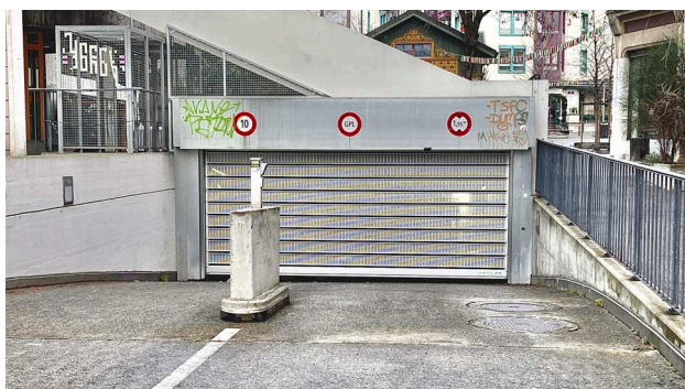
Image 4 - Entrée du parking souterrain
