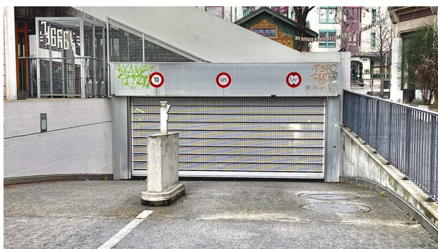
Image 4 - Entrée du parking souterrain
