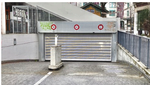
Image 4 - Entrée du parking souterrain
